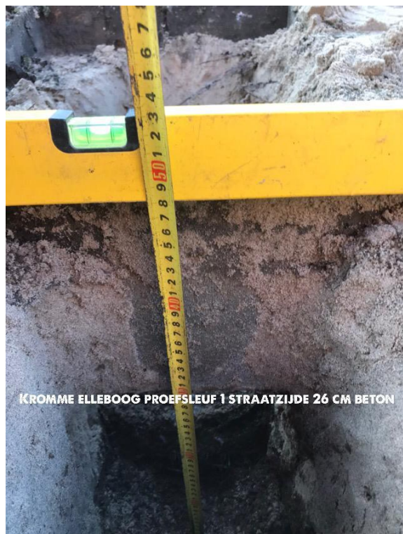
Proefsleuf 1, onderkant beton op 48 cm onder maaiveld. Dikte 26 cm beton.
