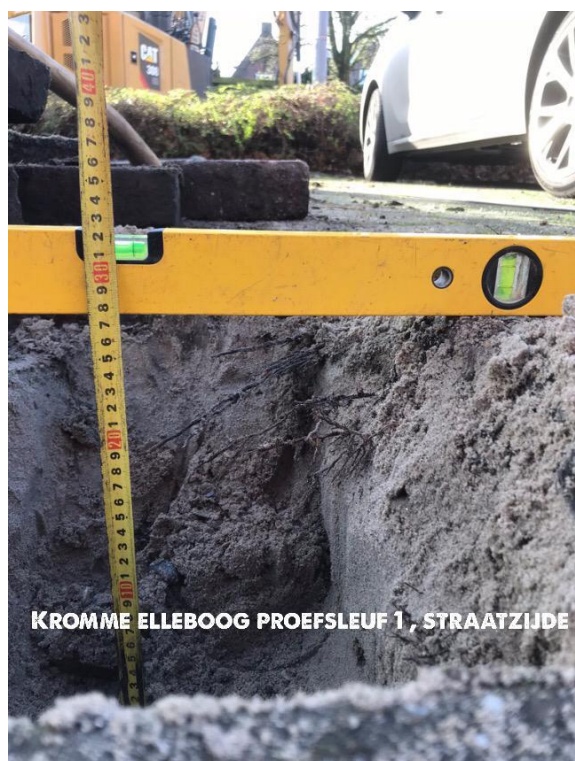
Proefsleuf 1, onderkant beton op 48 cm onder maaiveld. Dikte 26 cm beton.
