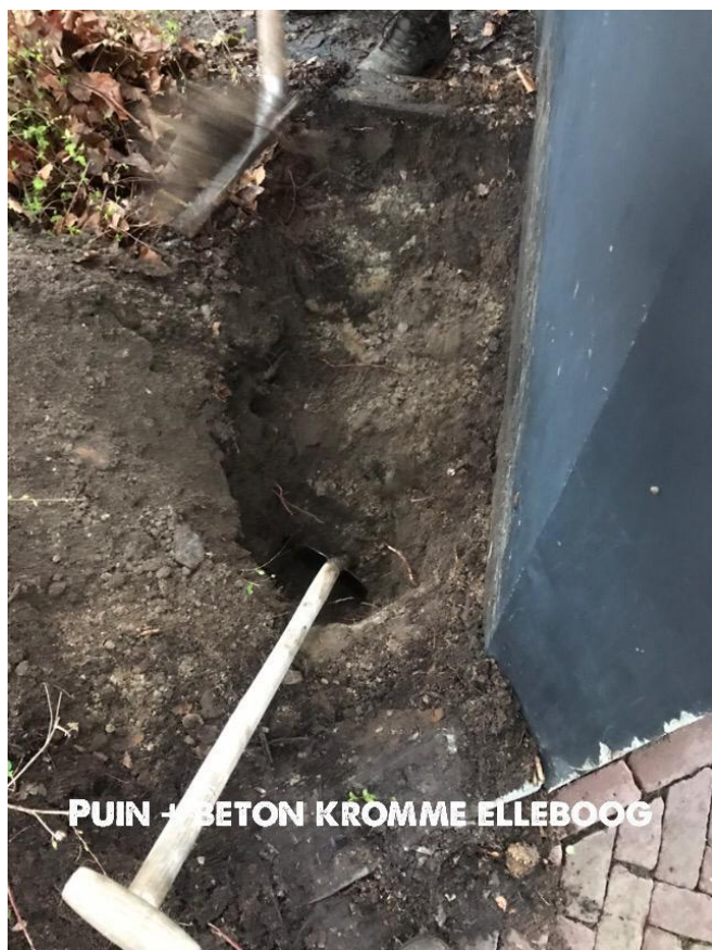
Proefsleuf 4, geen wortels gevonden alleen puin en beton. Maatvoering zie schets.
