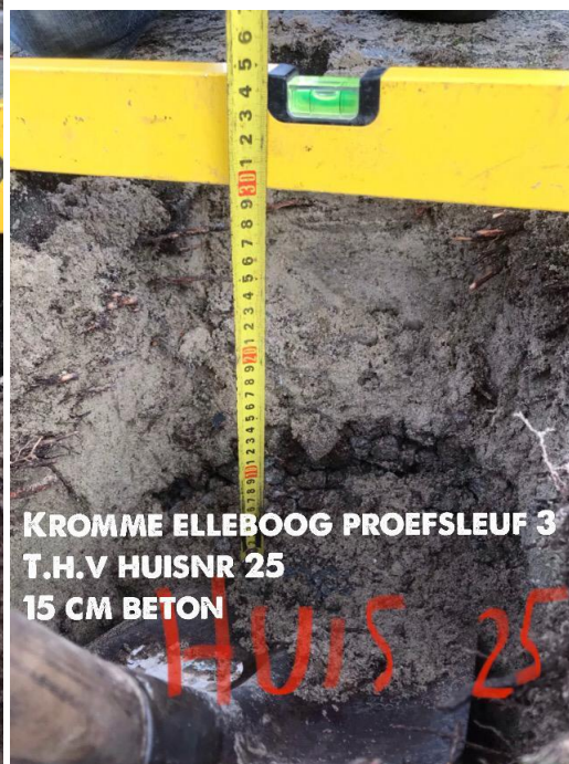
Proefsleuf 3 tbv opzoeken beton, 14 cm onder maaiveld gevonden. Maatvoering zie schets.
